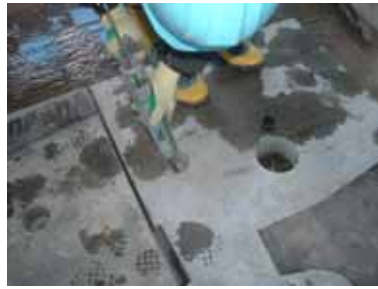
高さ調整ボルトの付着防止処理状況
