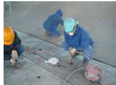
裏込めグラウトの注入状況
