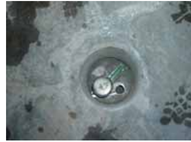
裏込めグラウトの注入前
