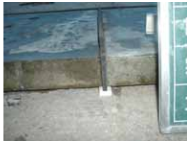
伸縮目地の取付け状況
