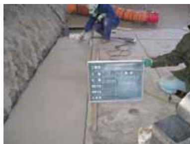
外周レジンコンクリート打設
