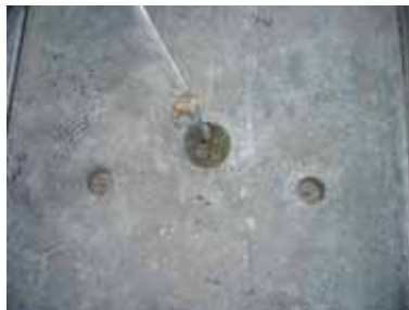
裏込めグラウトの注入完了
